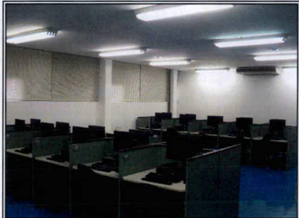
Central de Processamento de Dados
